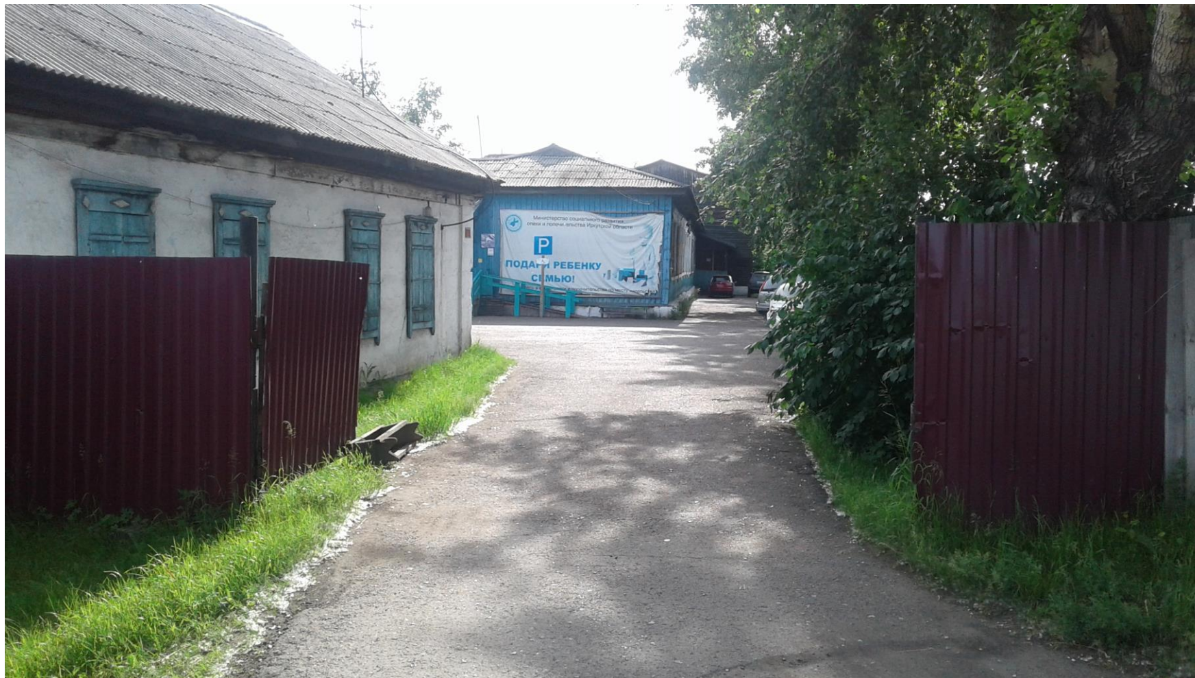
Фото №1 Вход на территорию объекта
