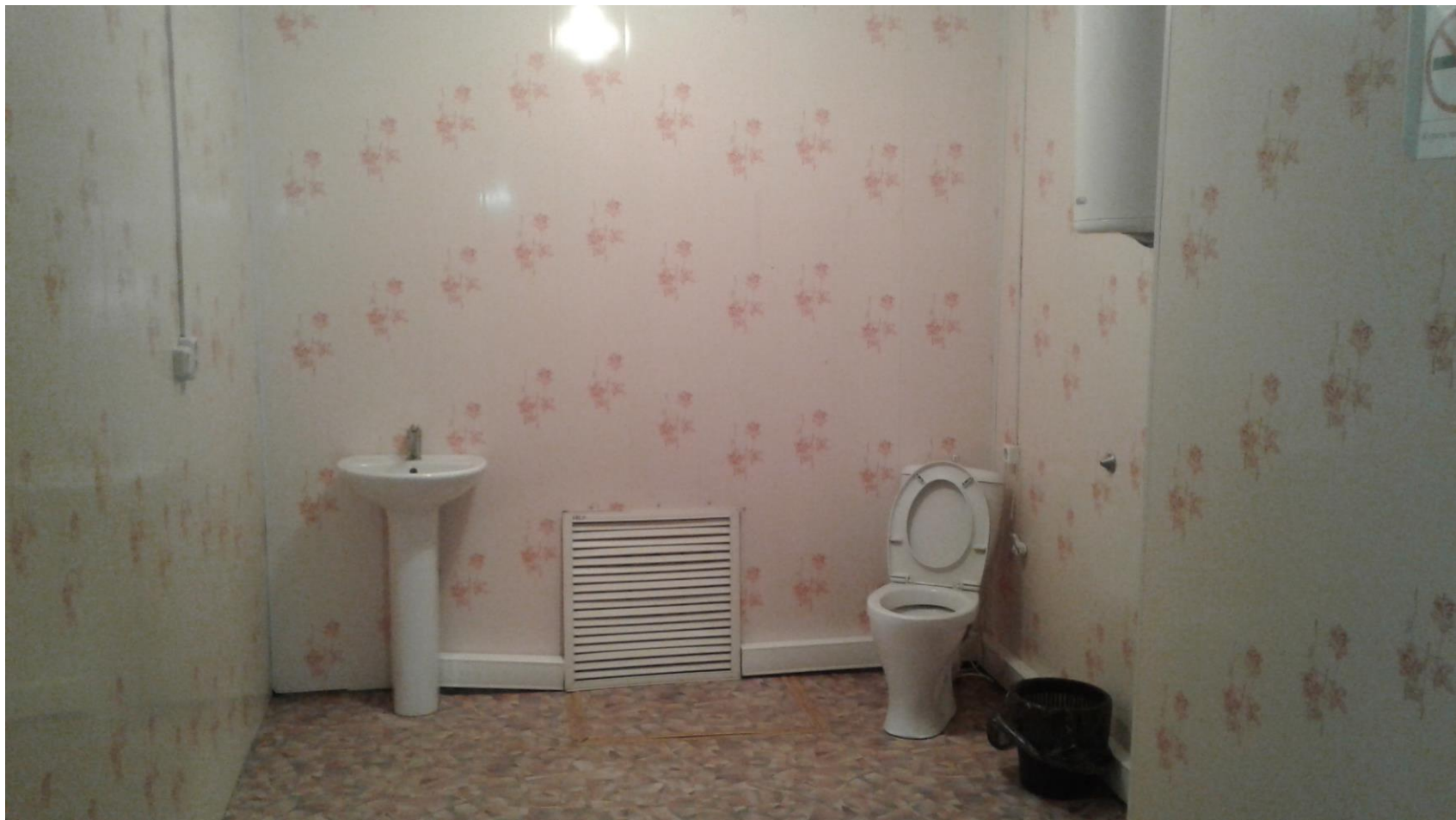
Фото № 12 Помещение туалета для посетителей МГН, помещение расположено на первом этаже здания № 2, согласно технического паспорта административно-учебного здания.
